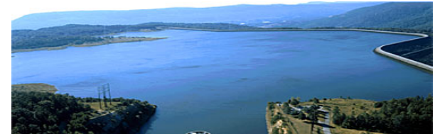
Szivattyús tározós vízerőmű
